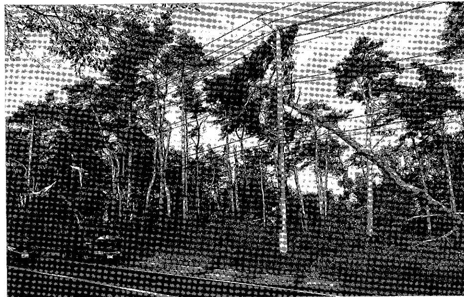
架空線、電柱にからむアカマツ群の倒木
