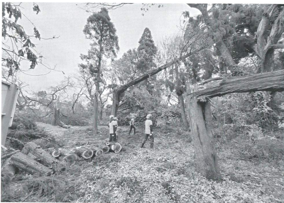
樹護士アーボリストたちによる現場の調査観察、プランニング。被害木は大径木が多く、折損木のかかり木、樹冠上部の折れ枝が複雑に絡み合い、架空線、構築物、道路にも2次損害を及ぼさないよう迅速に対処しなければならぬ状況だった
