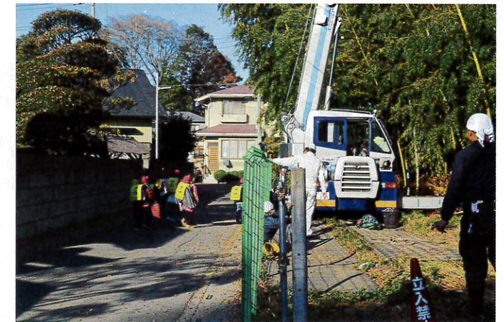
児童の通学路安全確保作業。道路沿いではクレーン車を使って行います
