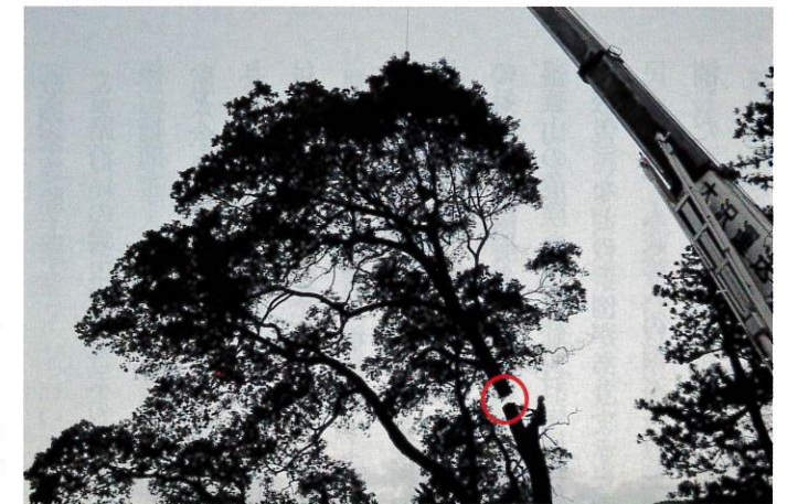
作業者が木に登り幹を切断します（写真の赤○部分）。切った幹をクレーンで吊り、安全な場所へ下ろします
